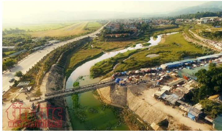
Di tích Cầu Mừng Thanh bắc qua sông Nậm Rốm.
